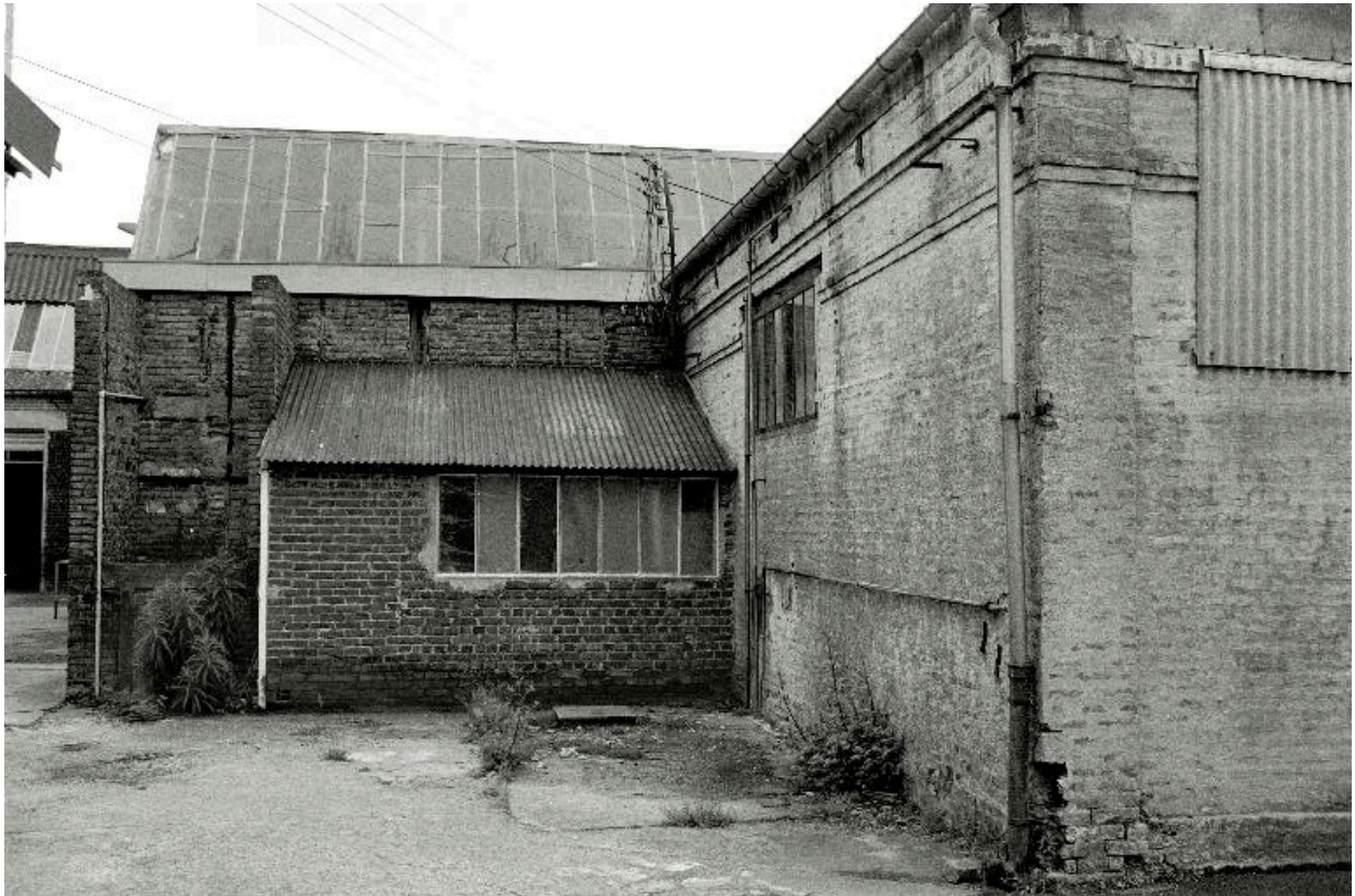
Atelier de fabrication, vue partielle, en 1990.
