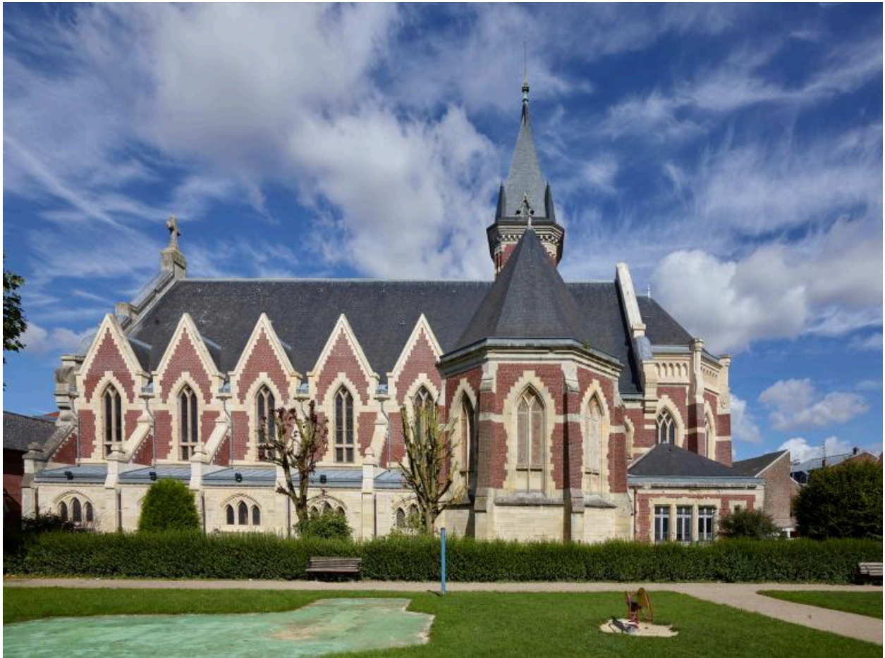
Vue générale extérieure de l'église côté sud depuis le jardin des mères.
