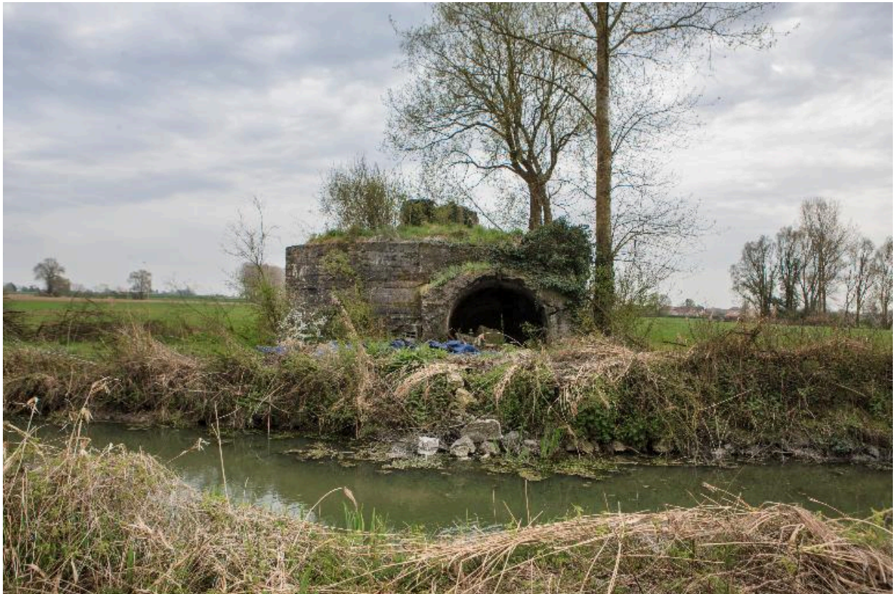
Edifice b. Vue de trois-quarts vers le sud-ouest
