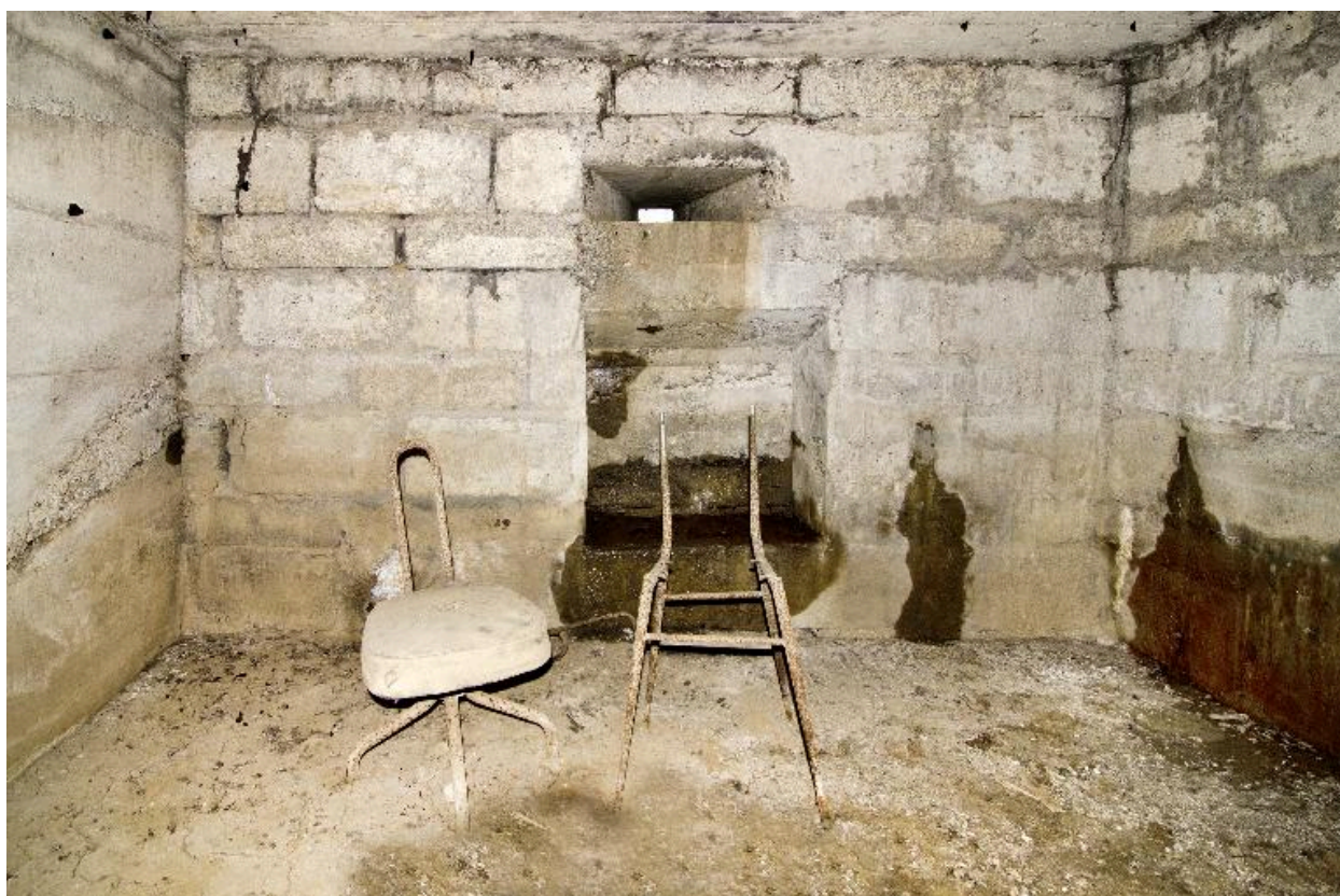
Salle sud, vers l'ouest
