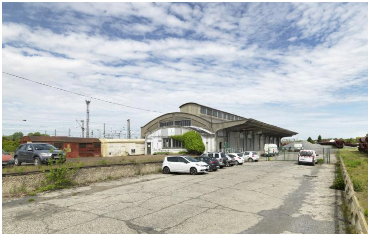
Halle de marchandises de type 2bis à 10 portes. Vue depuis le sud-est.
