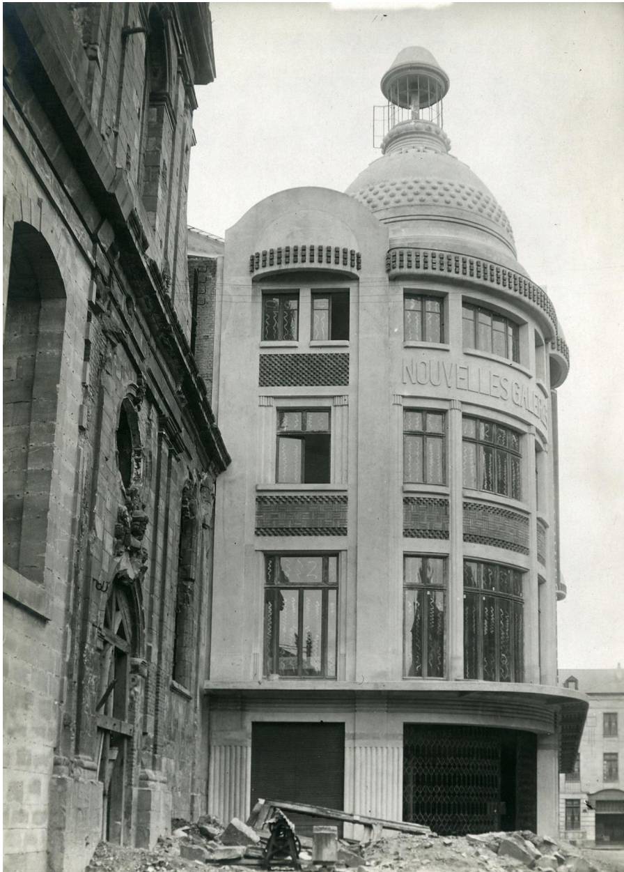
Chantier de construction des Nouvelles Galeries, rotonde de la rue Saint-Jacques, vers 1926. (Cité de l'Architecture et du Patrimoine ; fonds des Bétons armés Hennebique ; 3-D-369).
