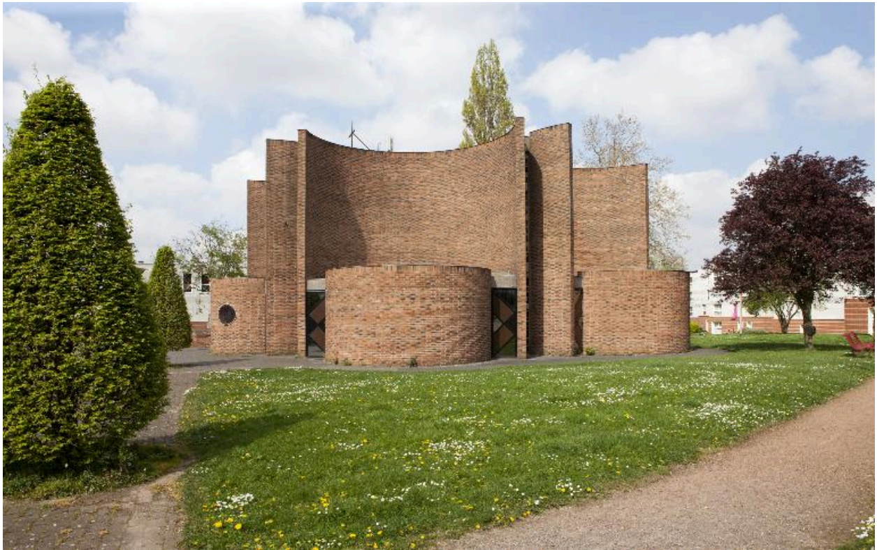
Élévation sud-est de l'église.
