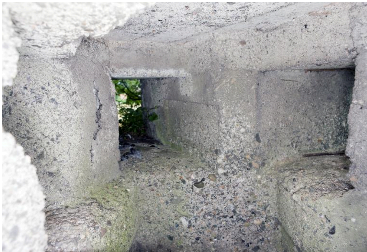
Intérieur de la tour de communication optique. Vue horizontale depuis l'embrasure ouest
