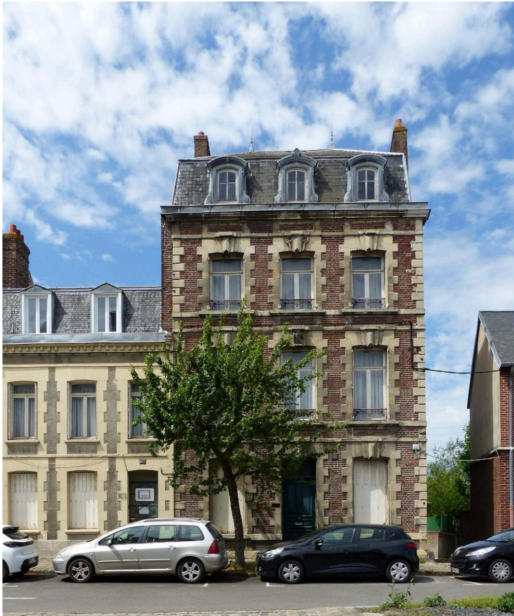
Maison, rue Saint-Fursy.
