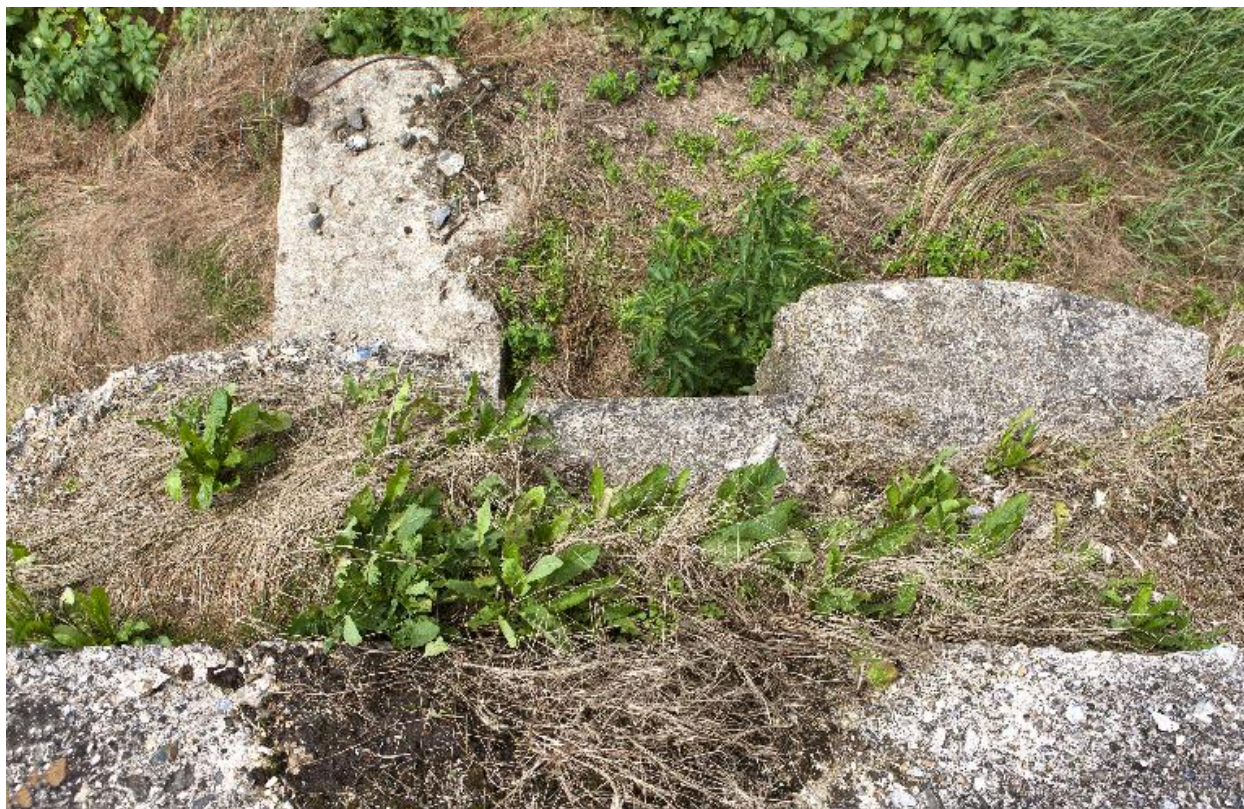
Vue de dessus du porche pare-souffle
