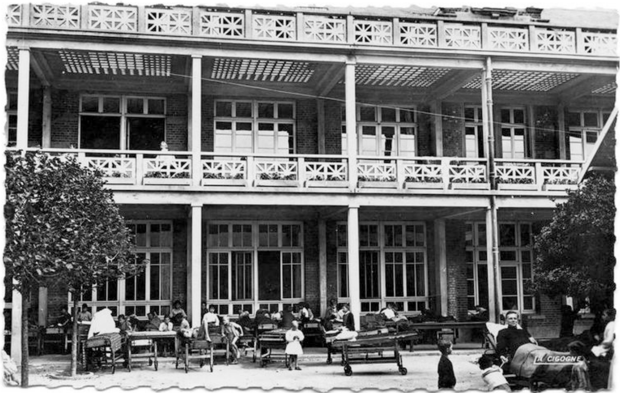
Bâtiment d'hospitalisation ajouté dans l'entre-deux-guerres au nord de l'établissement, élévation sur la cour avec ses galeries de cure d'air superposées. Carte postale, milieu du 20e siècle (coll. part.).
