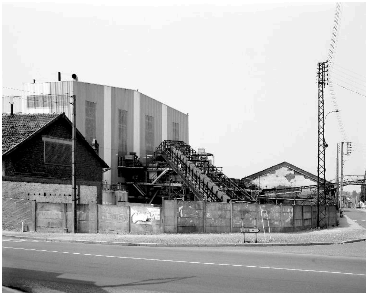
Atelier de fabrication, vue partielle, flanc nord.
