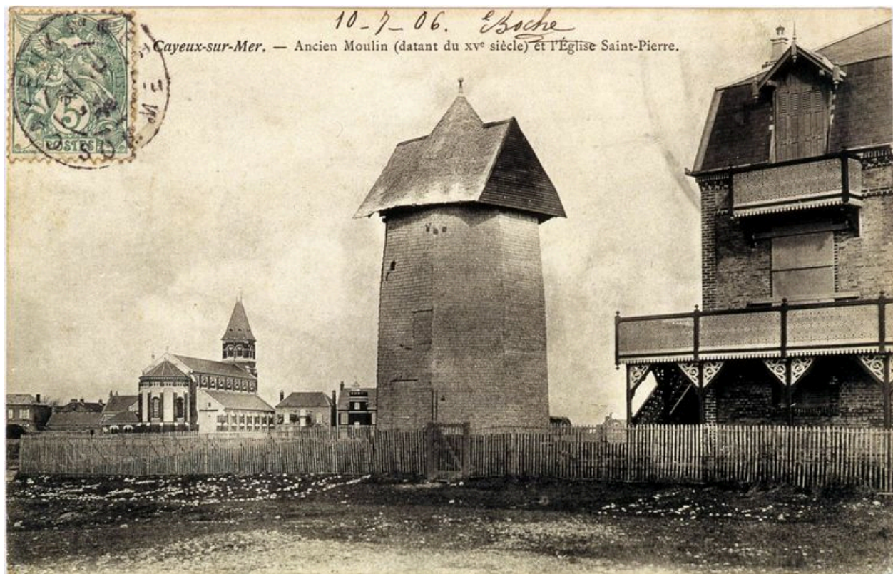
La maison avant transformations, carte postale, 1er quart 20e siècle (coll. part.).
