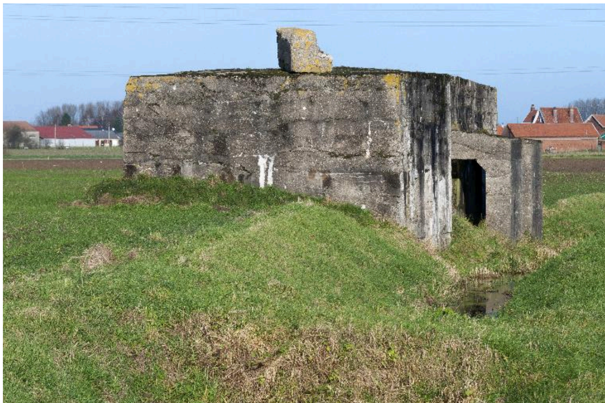
Vue de trois-quarts, vers le nord-ouest
