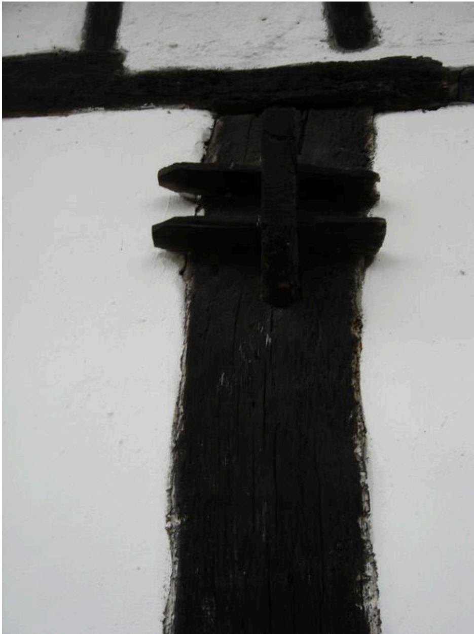
Vue détaillée de la boutisse débordante à double tenon passant.
