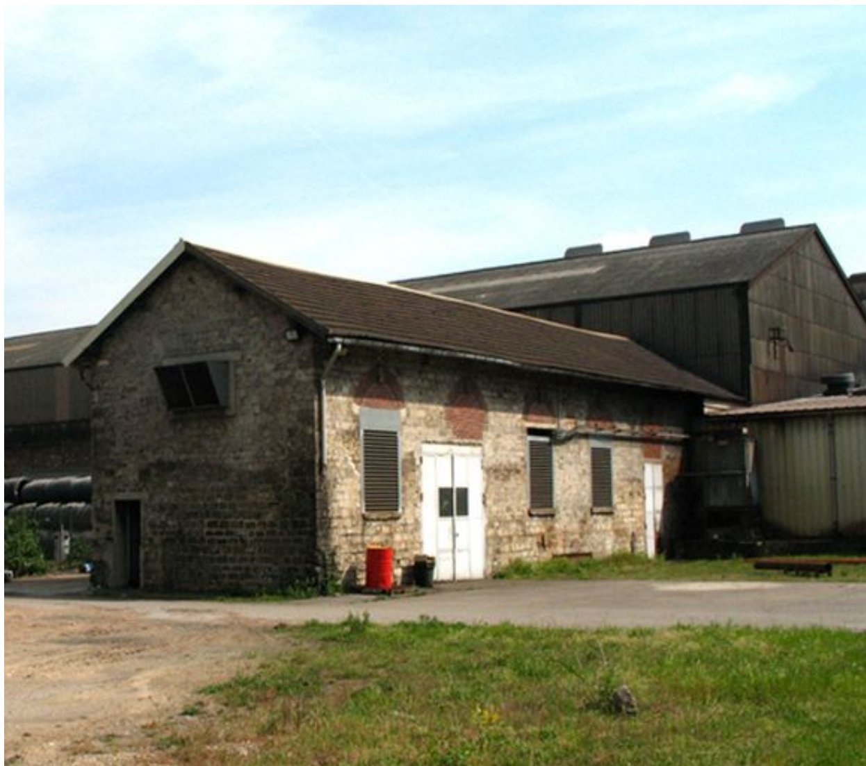
Atelier de fabrication ayant abrité des fours.
