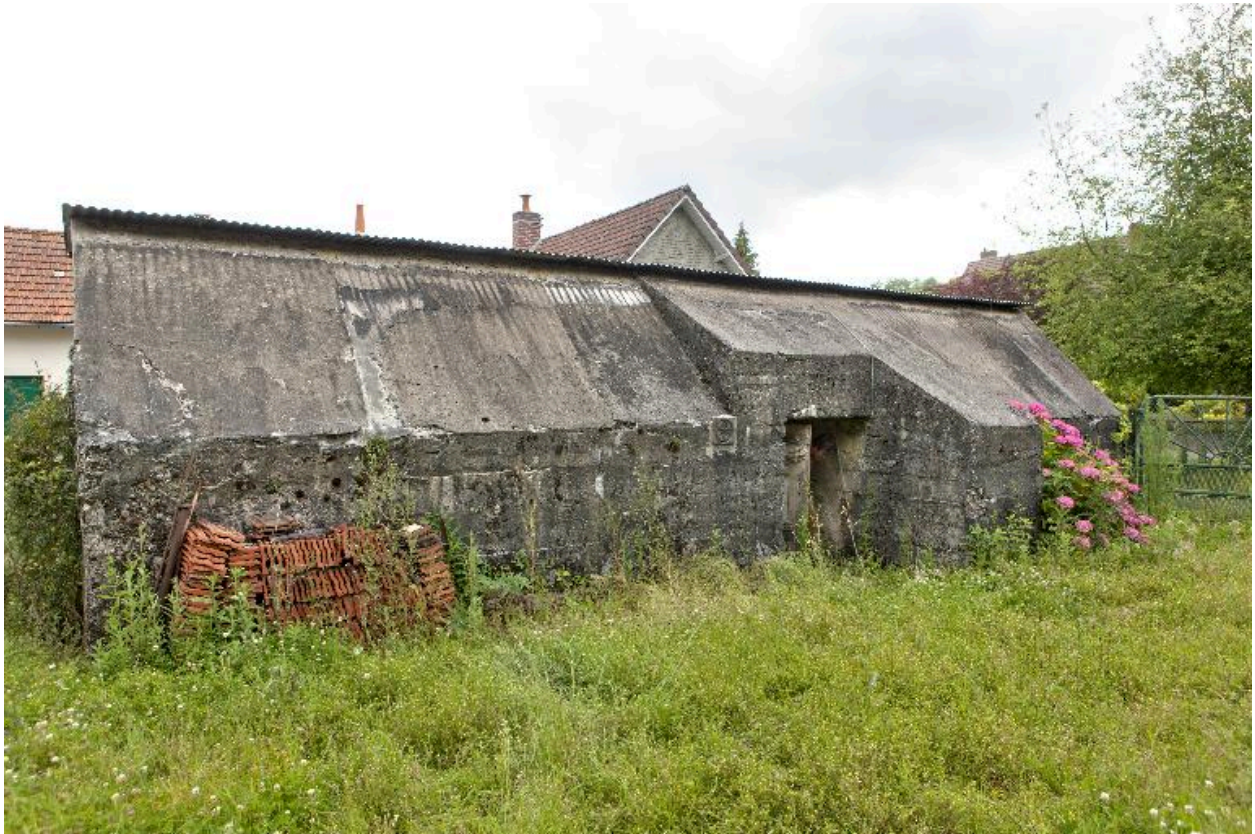
Vue générale, vers le nord-est
