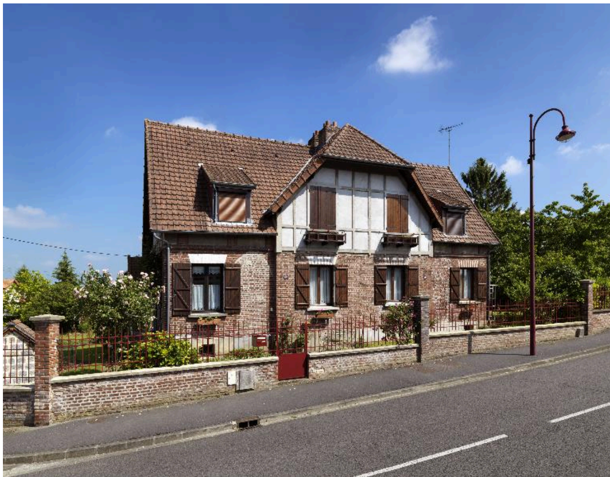
Maison d'employés à deux unités d'habitation de type E (105-107 rue Paul-Doumer).
