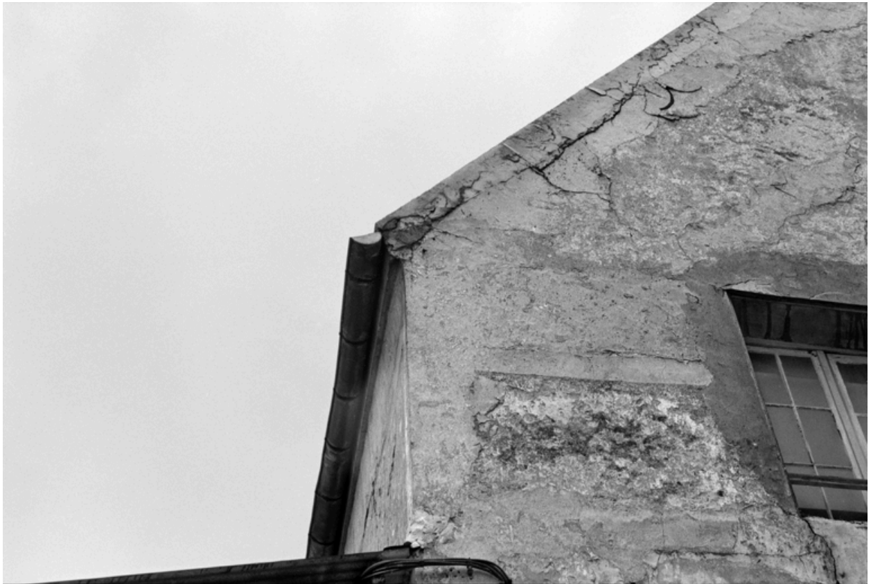
Vue de la chapelle et détail de la façade ouest.
