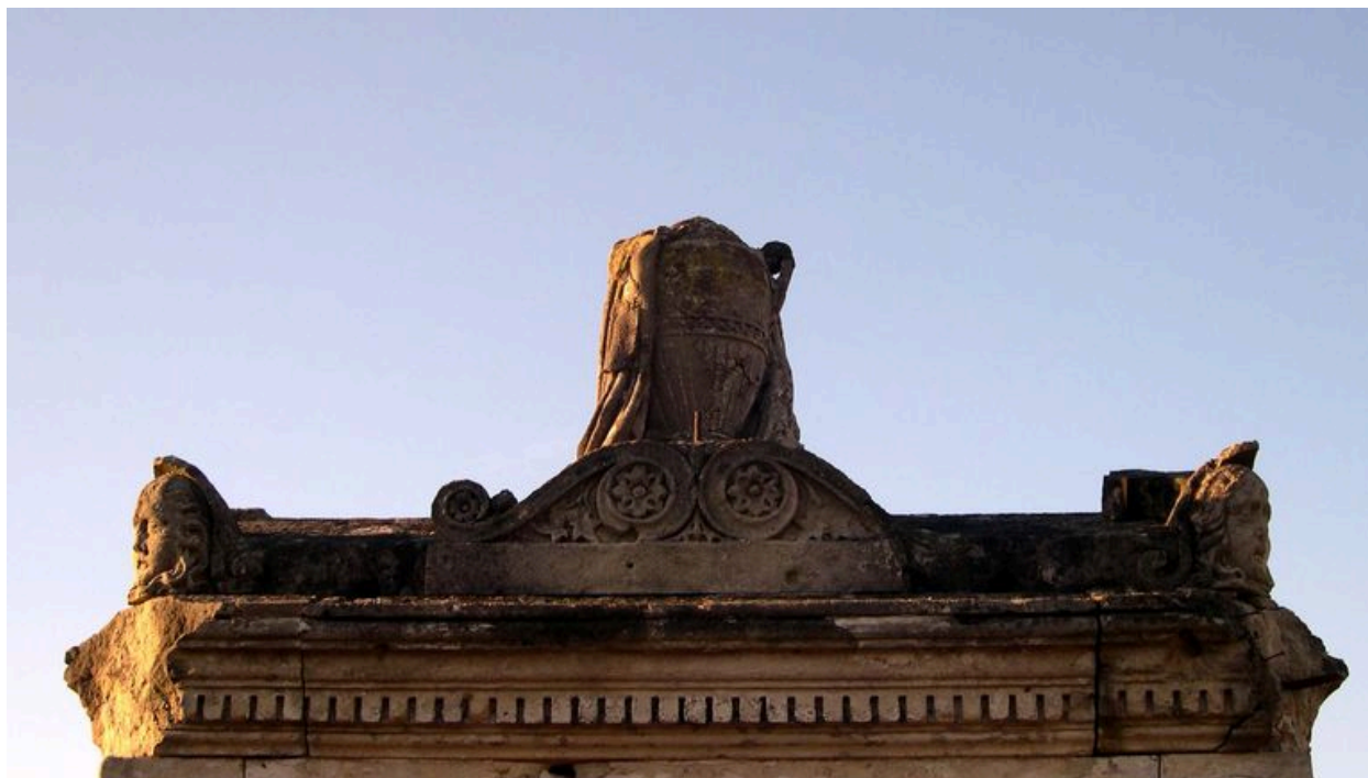
Vue de détail du couronnement, face sud.
