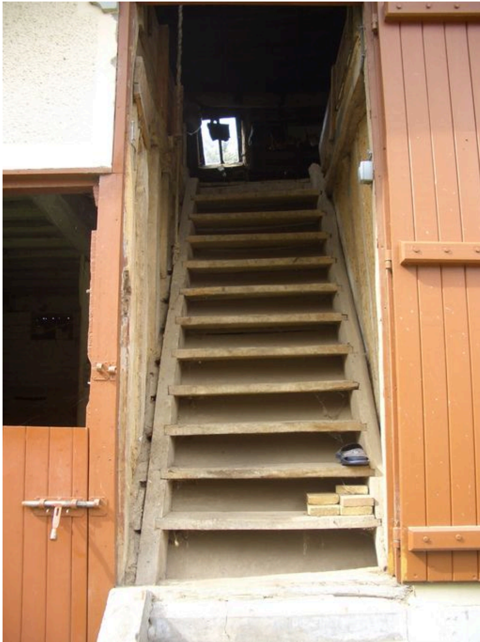
Vue de l'escalier de meunier menant au grenier, entre l'écurie et la chambre.
