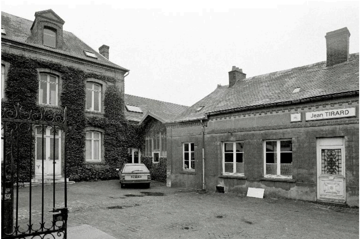
L'ancien logement patronal (vers 1894) et un ancien logis de ferme transformé en atelier (détruit), vus depuis le sud-est en 1990.
