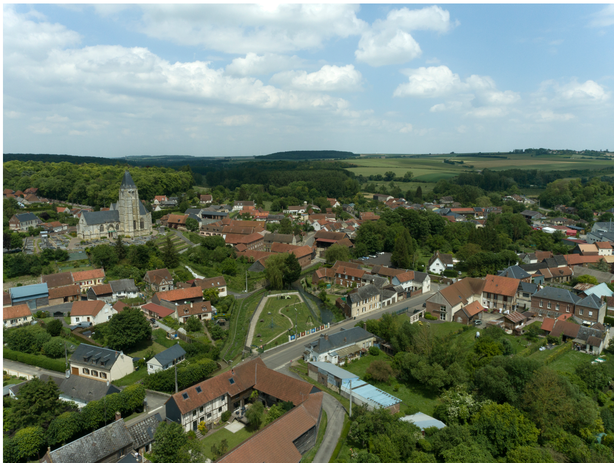
Vue générale du village depuis le sud-ouest.
