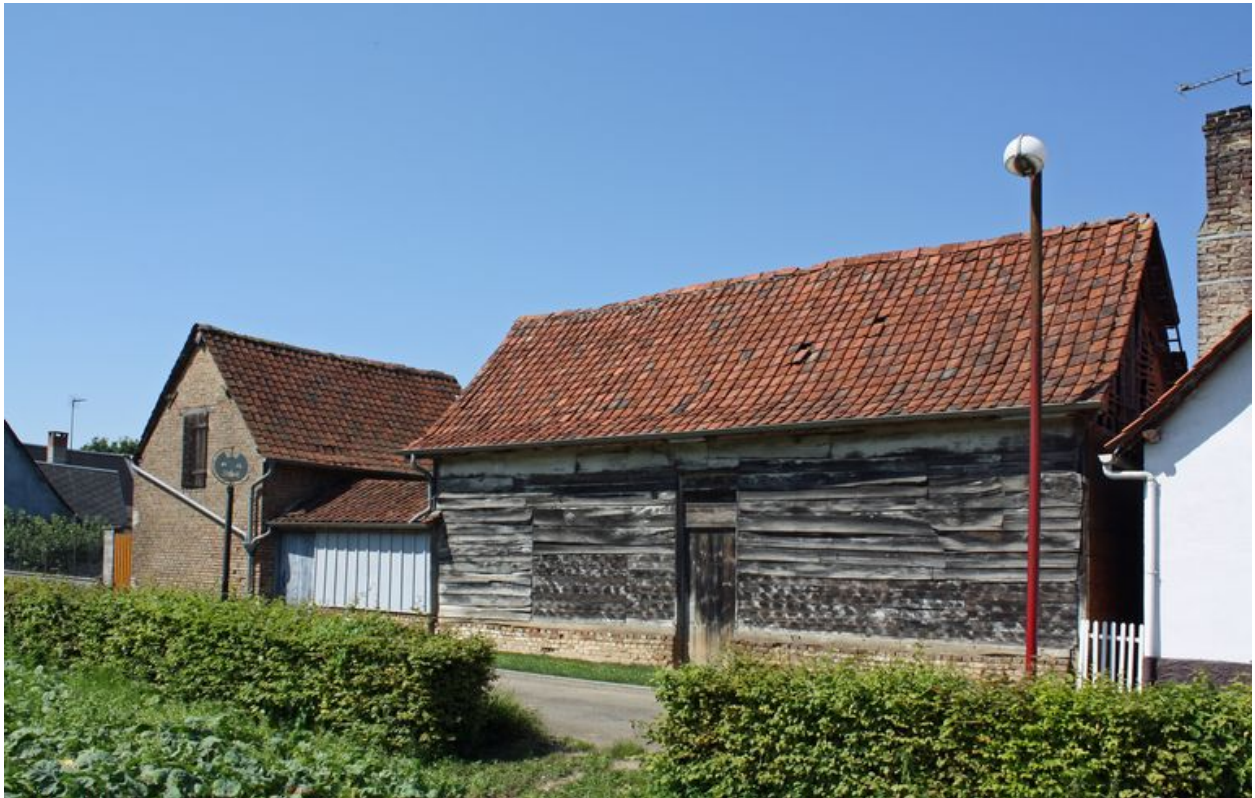
Ville-le-Marlet, ferme, rue de la Voie, début du 19e siècle.
