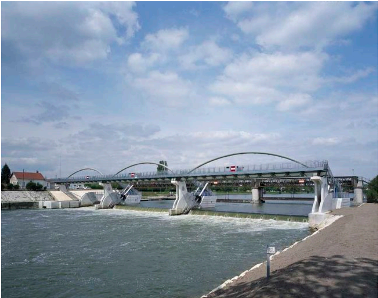
Creil : barrage à clapets.
