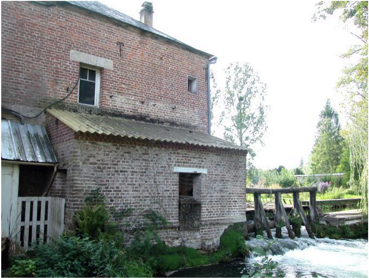
La cage du moulin et le vannage de décharge.
