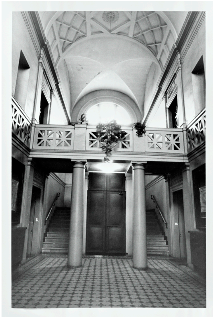
La salle des pas perdus en 1976, vue de la porte d'entrée (cliché CRMH).
