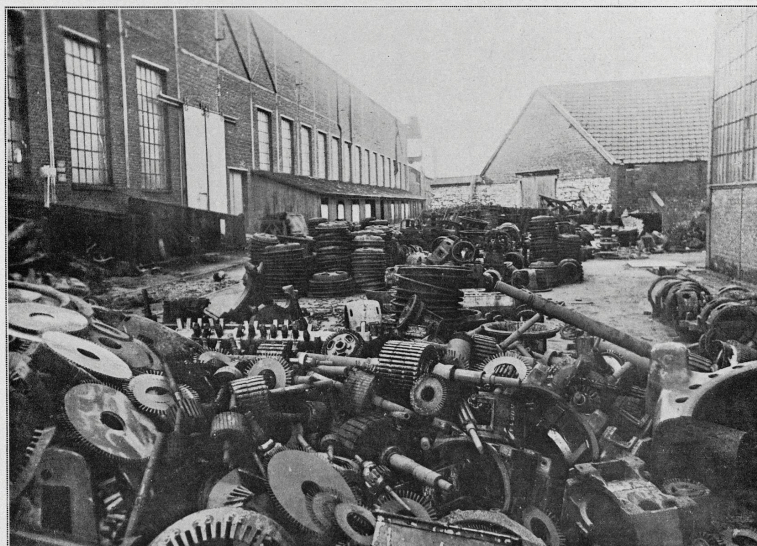
Toutes les machines, dynamos, moteurs, transformateurs, etc., ont été dépouillés de ce qui était cuivre et mis pile-à-pile à la ferraille.
