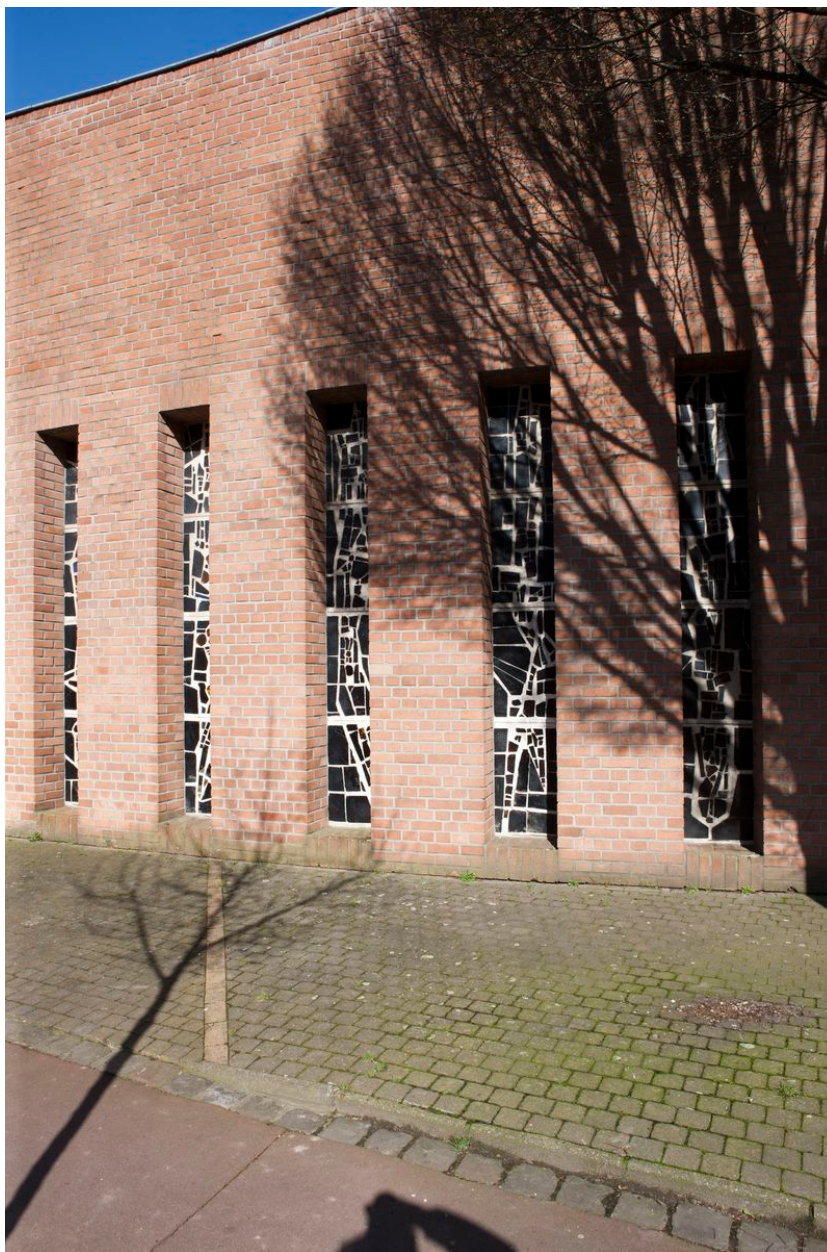
Verrières du flanc gauche.
