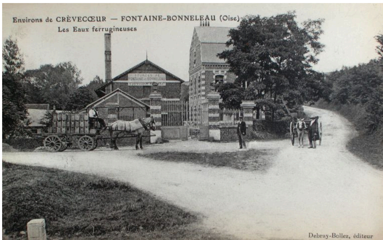
Vue d'ensemble de l'usine, vers 1910.
