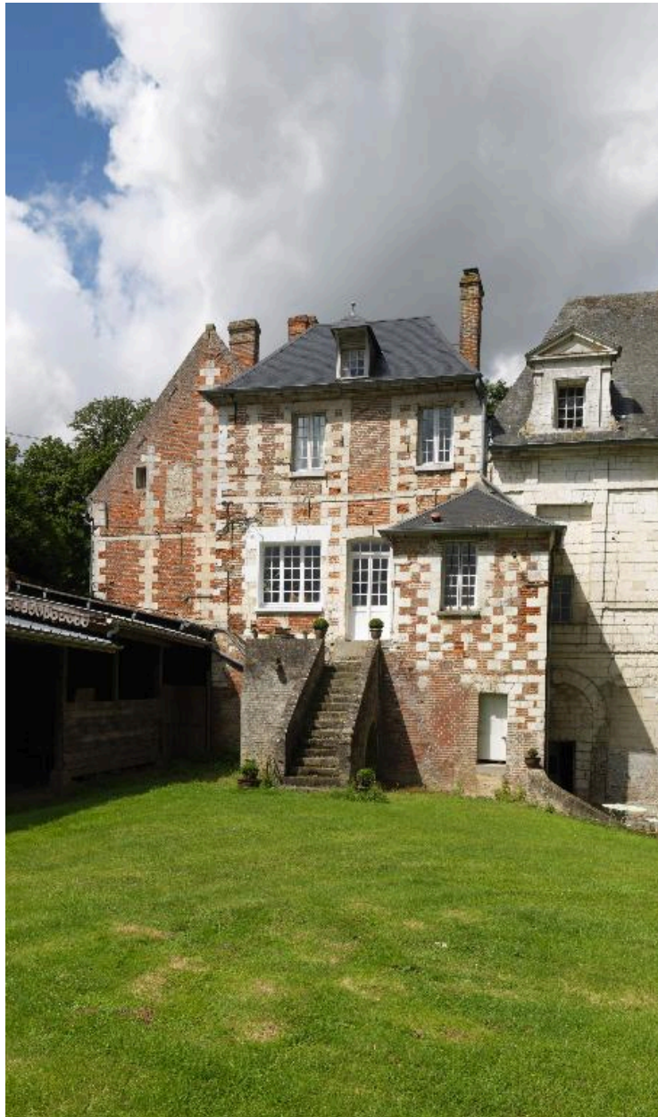
Elévation arrière du pavillon est du logis sur la basse-cour.
