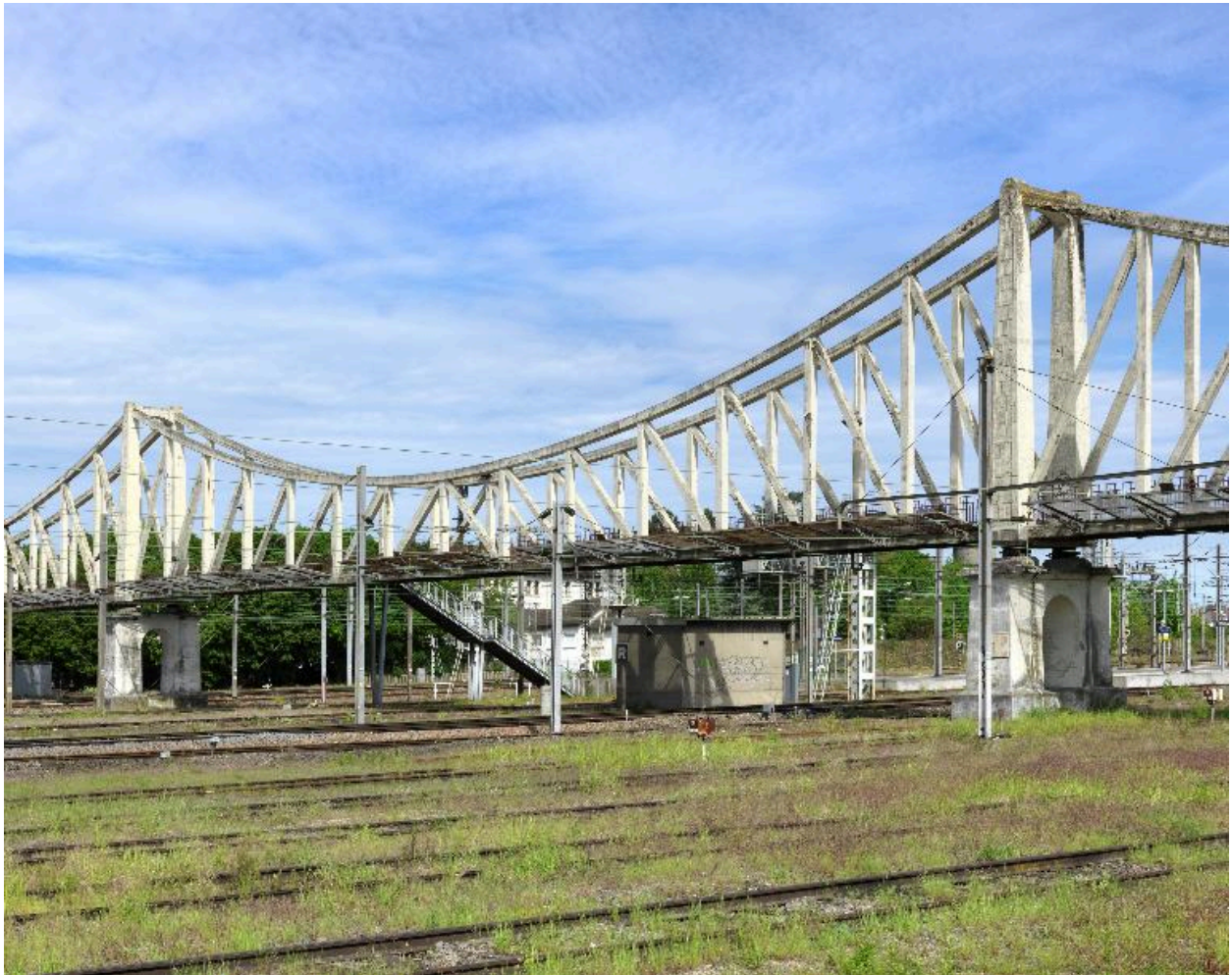
Vue du tablier central de la passerelle.
