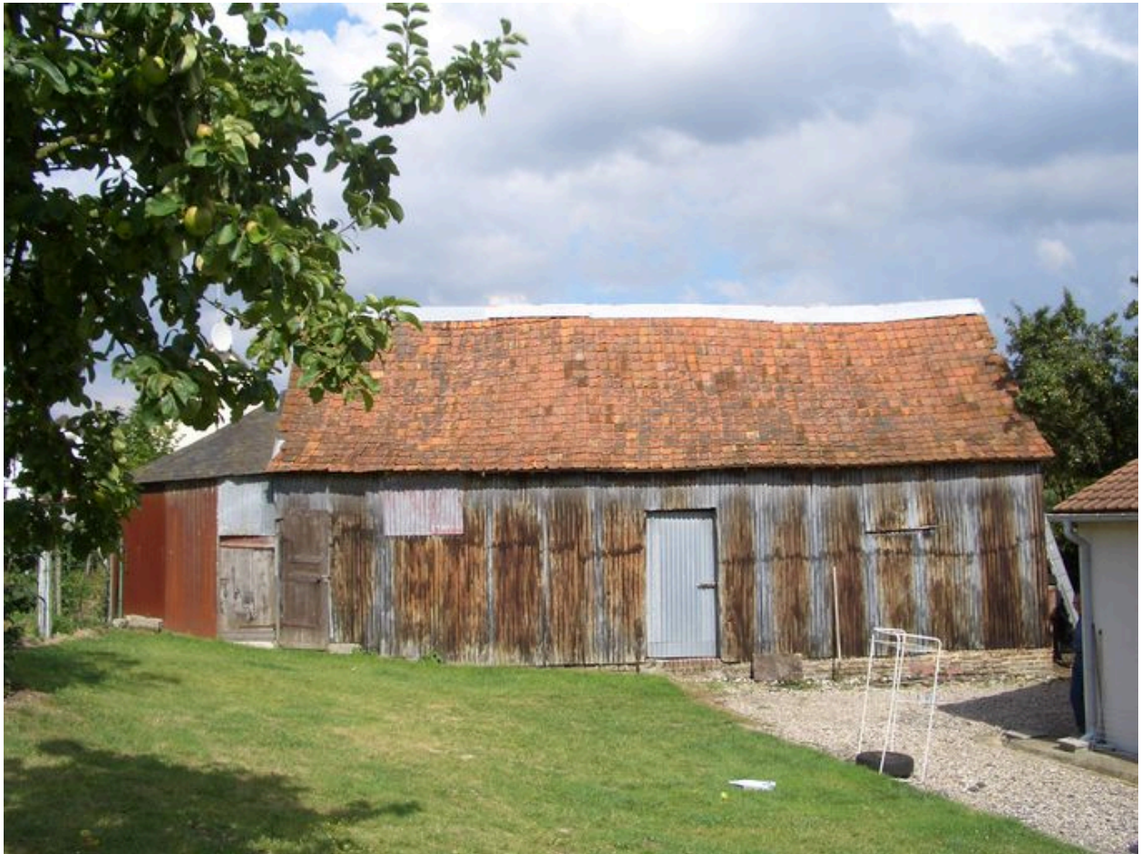
Vue de la grange.
