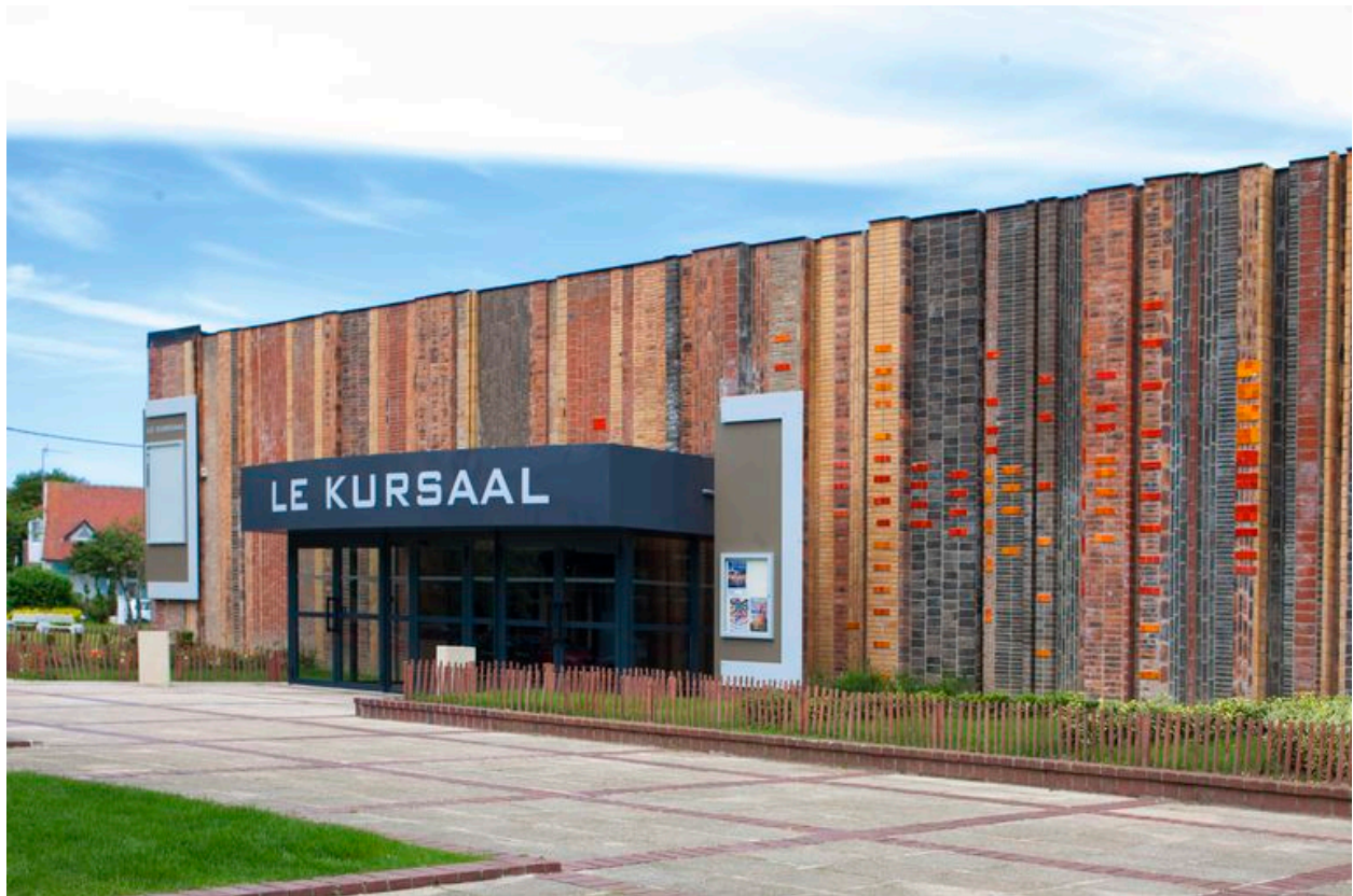
Vue de trois quarts de l'entrée.
