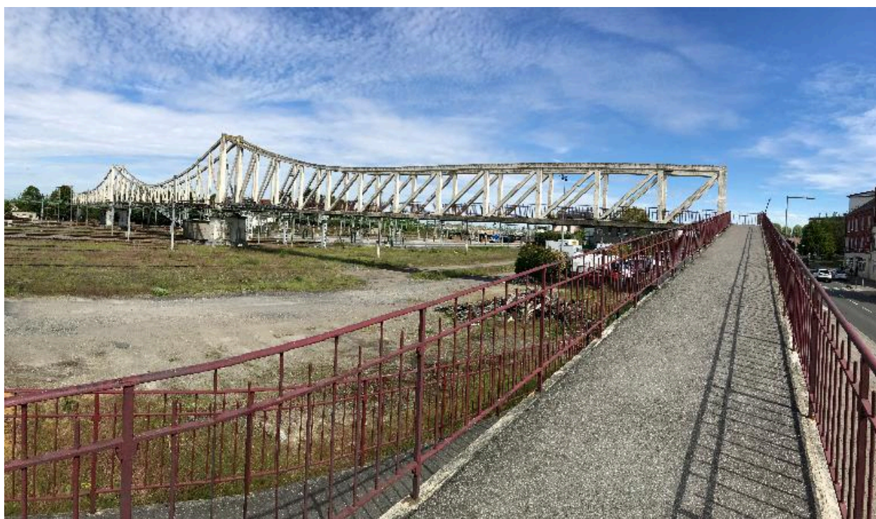
Rampe d'accès piéton à la passerelle.
