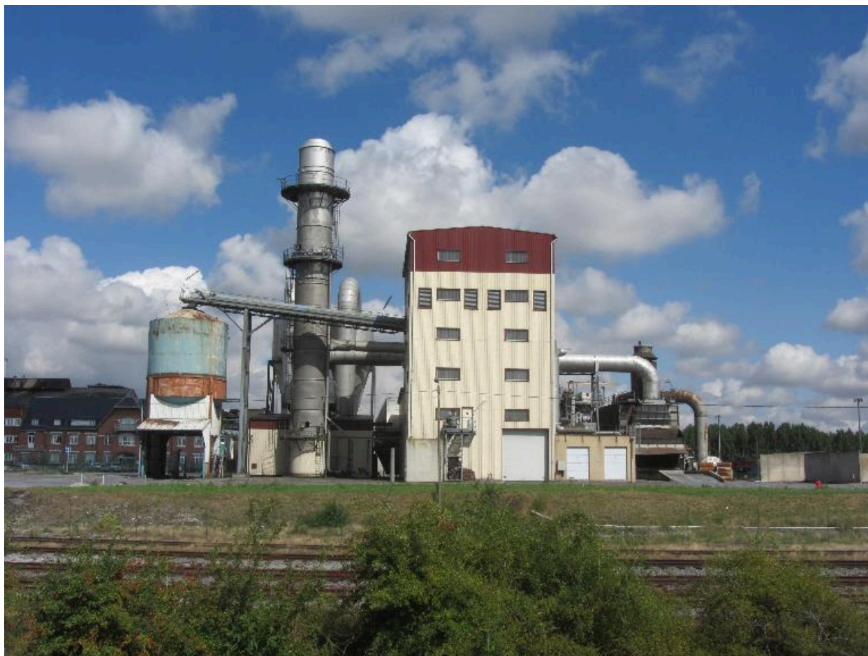
Vue d'ensemble de l'unité de déshydratation des pulpes de betteraves.
