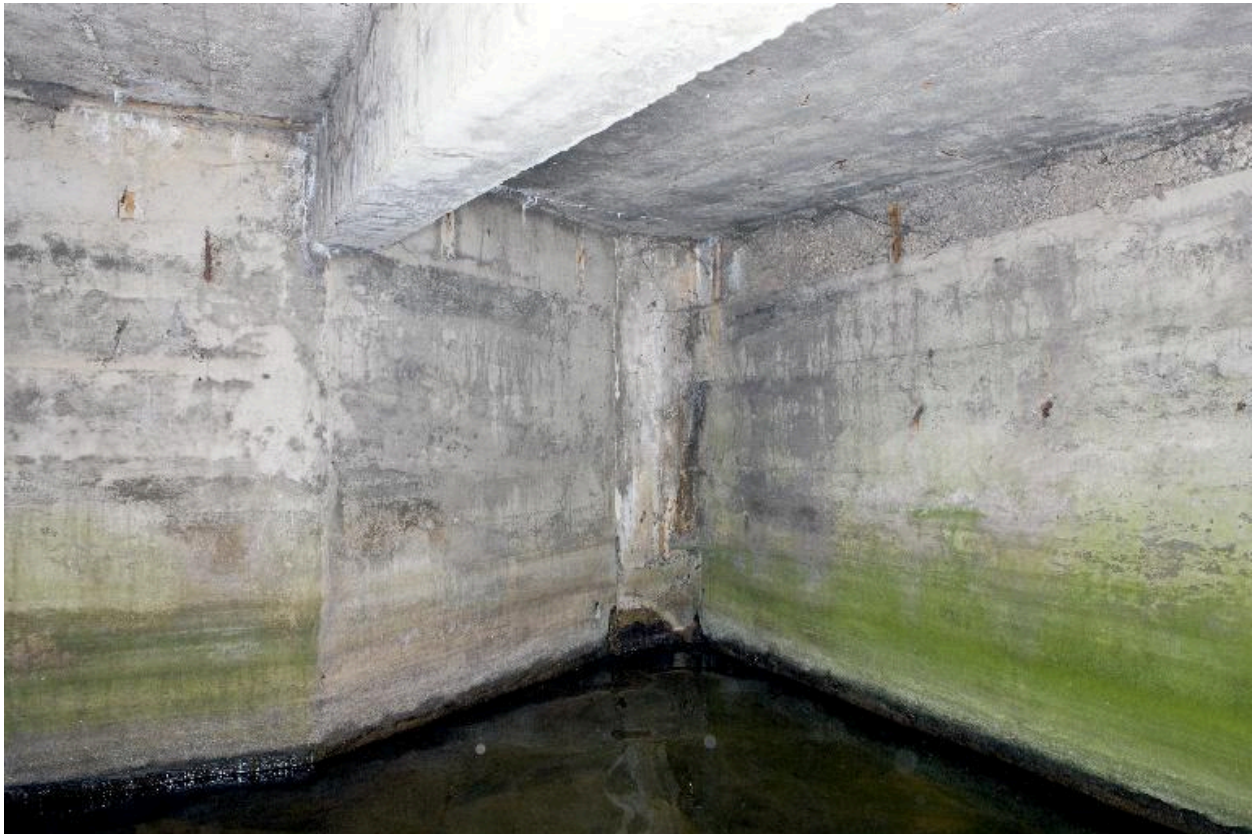
Vue intérieure de la soute à munitions, vers la chambre de tir
