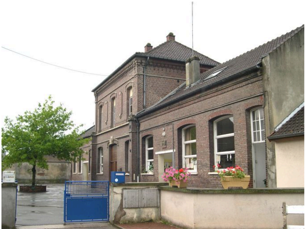
Vue de la façade sur cour.
