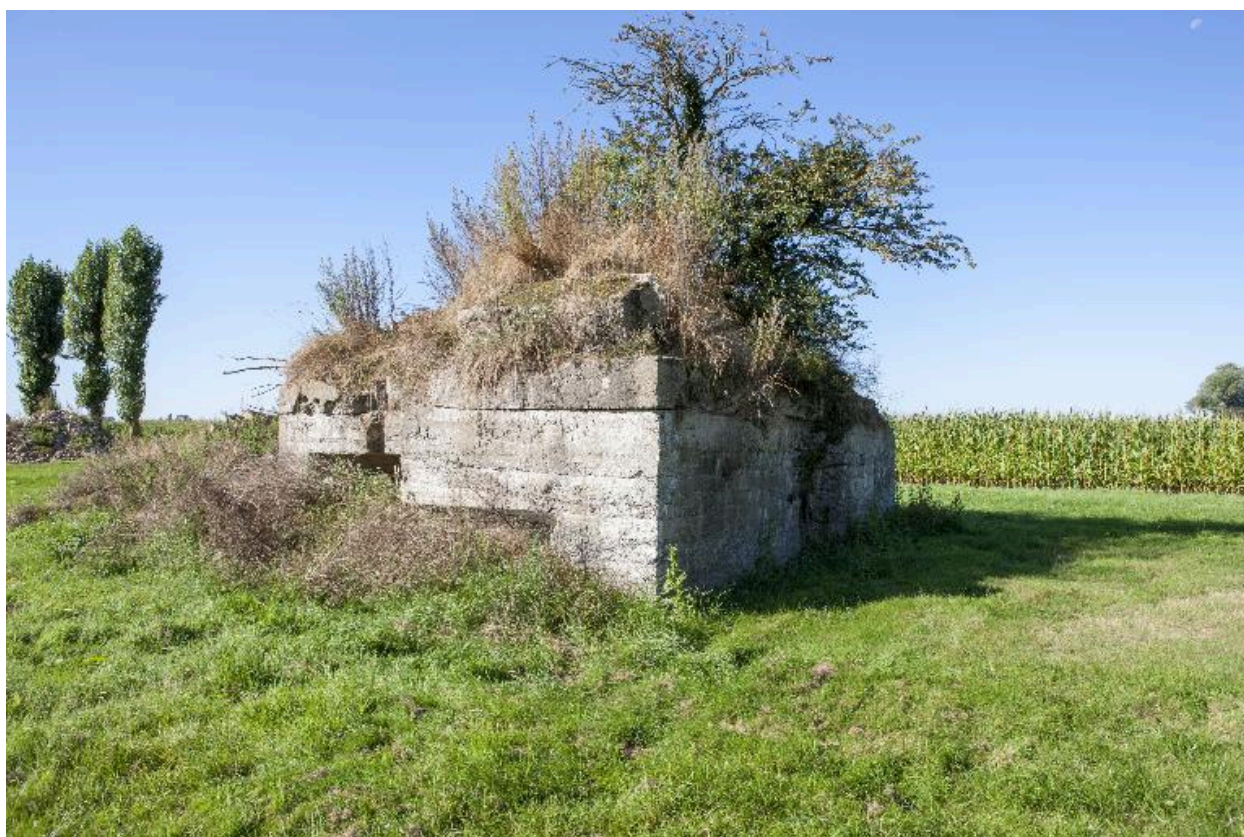
Vue vers le nord-ouest
