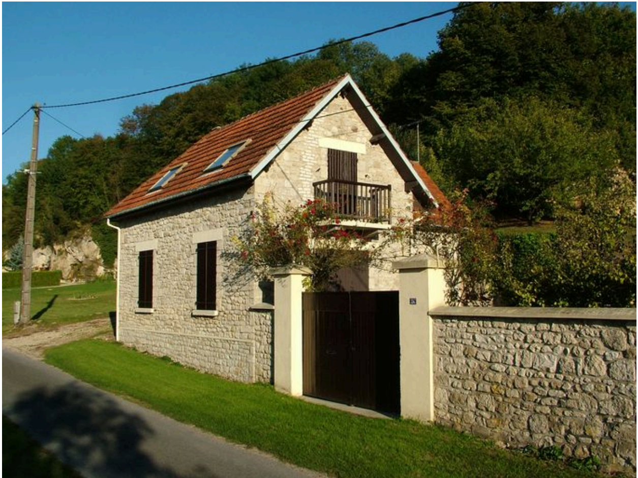
Vue générale des dépendances.
