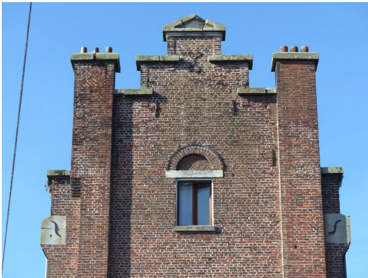
Vue du pignon est.
