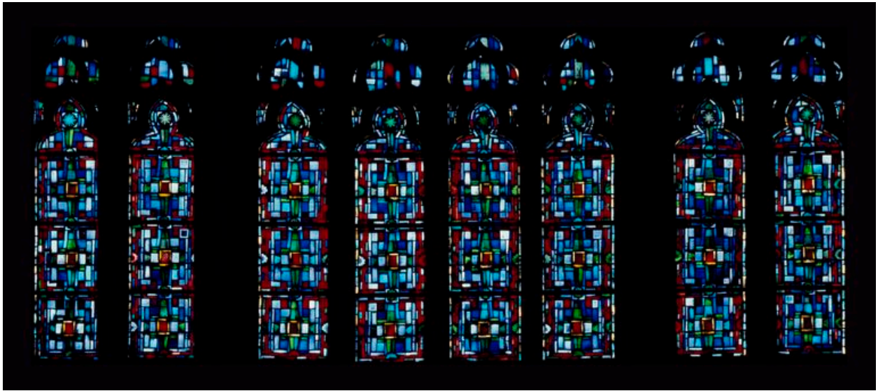
Vue générale de la verrière de la baie 119.
