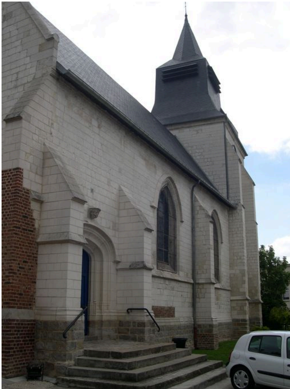
Vue de la façade sud.
