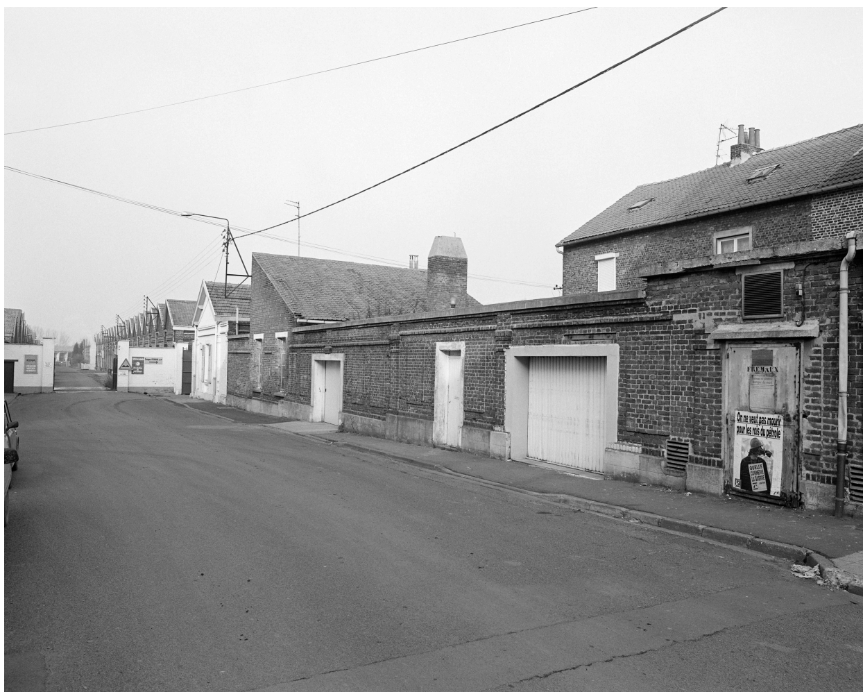
Atelier de fabrication, élévation rue d'Écosse.
