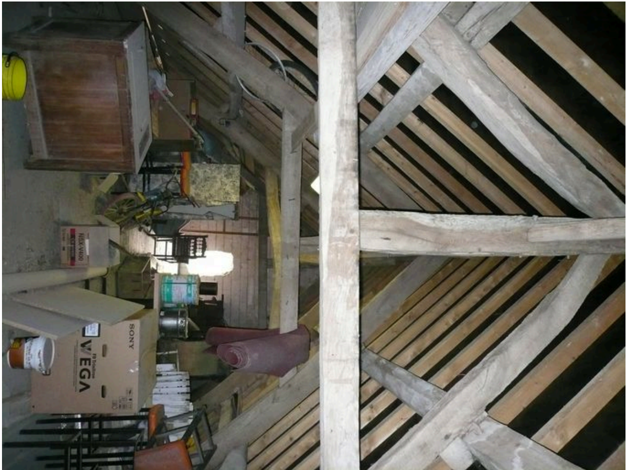
Vue de la charpente des écuries.
