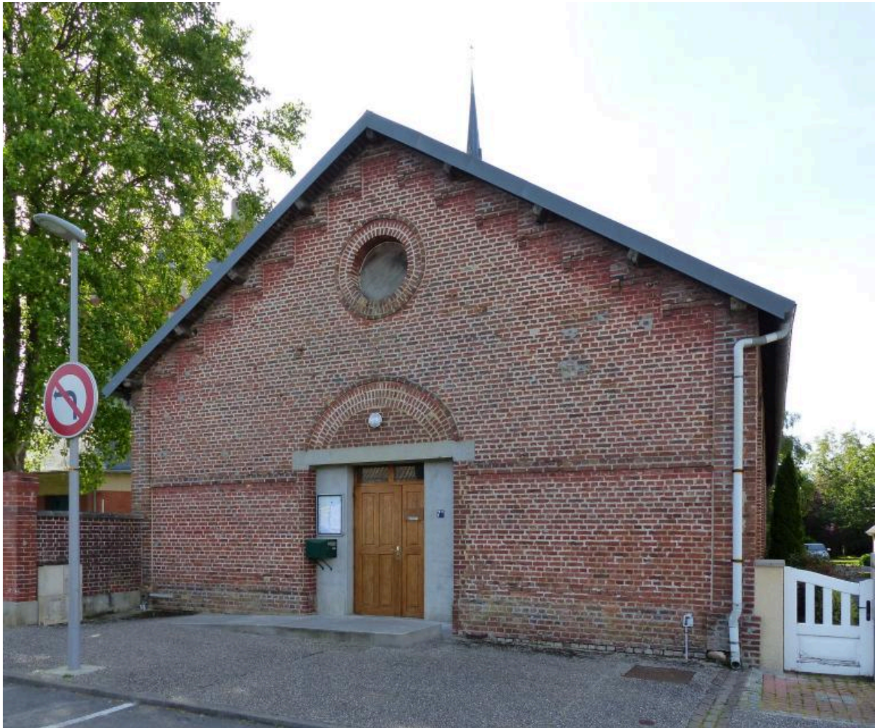
Vue de la façade principale au nord.
