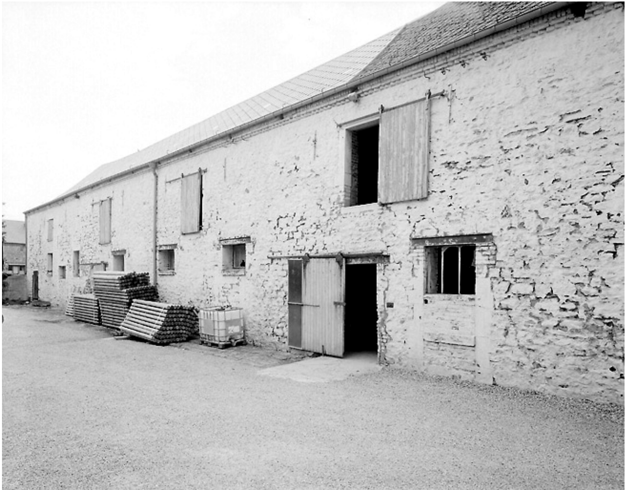
Vue des étables-fenil depuis la cour.
