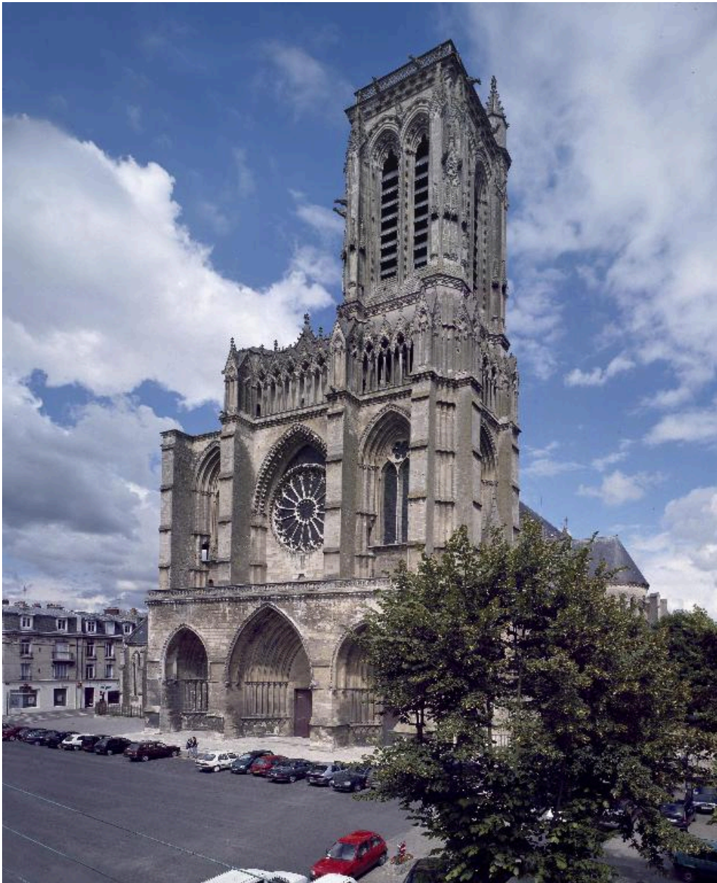
Vue générale de la façade depuis le sud-ouest.
