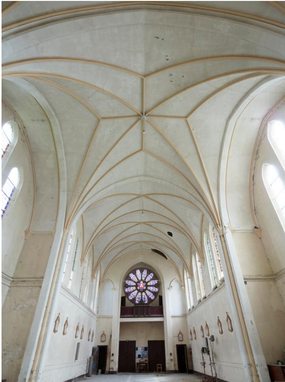
Vue des voûtes à liernes et tiercerons à la croisée du transept.
