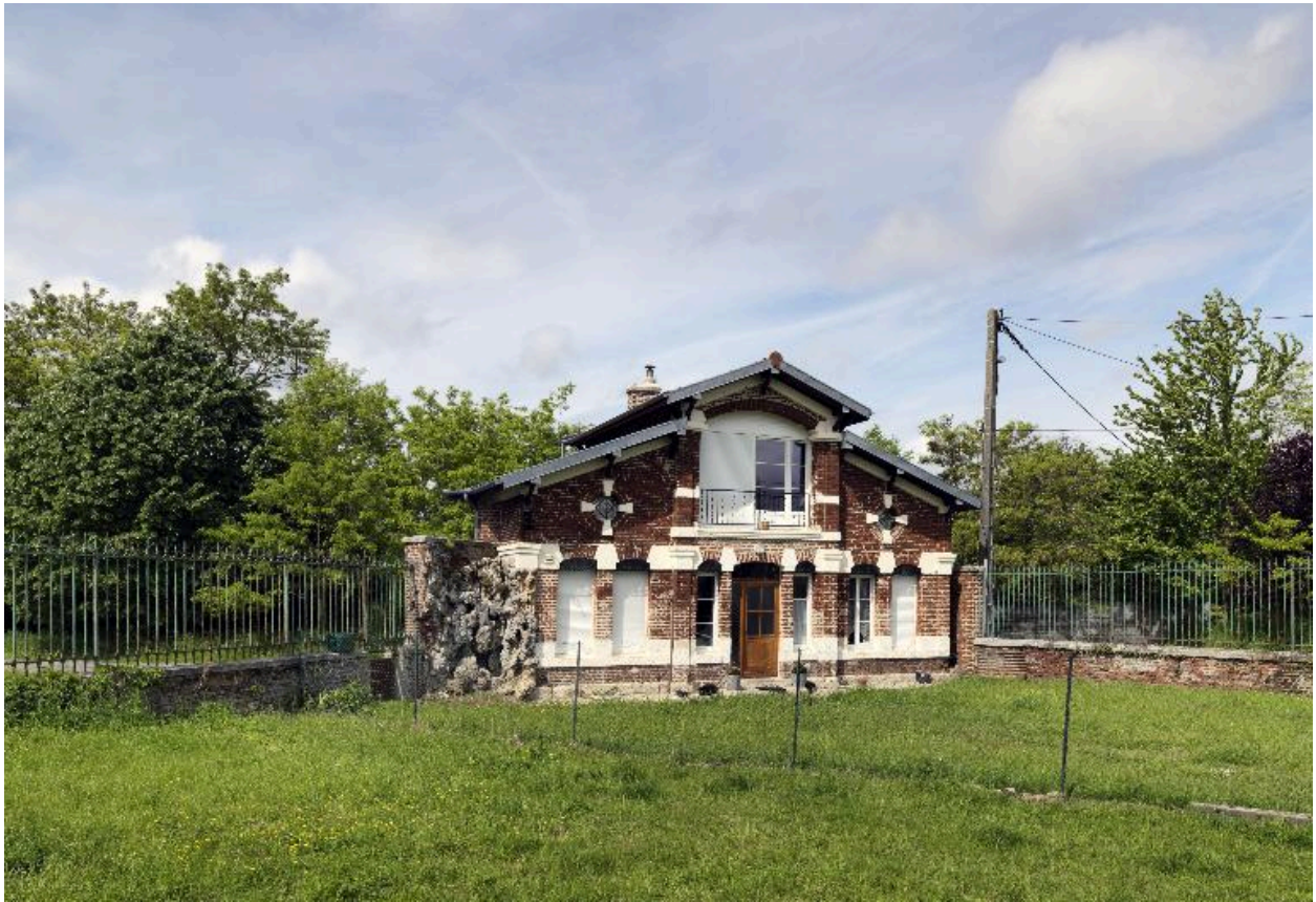
La maison de gardien à l'entrée latérale du château Maguin, façade sur cour.
